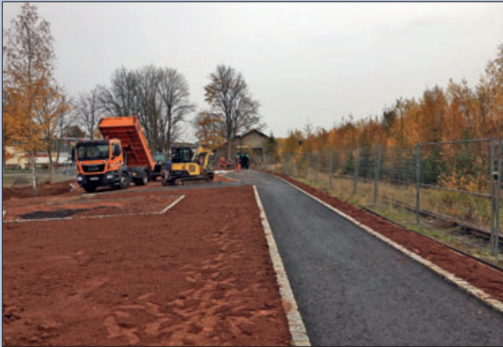
Baufreimachung Gelände, Geländeregulierung
