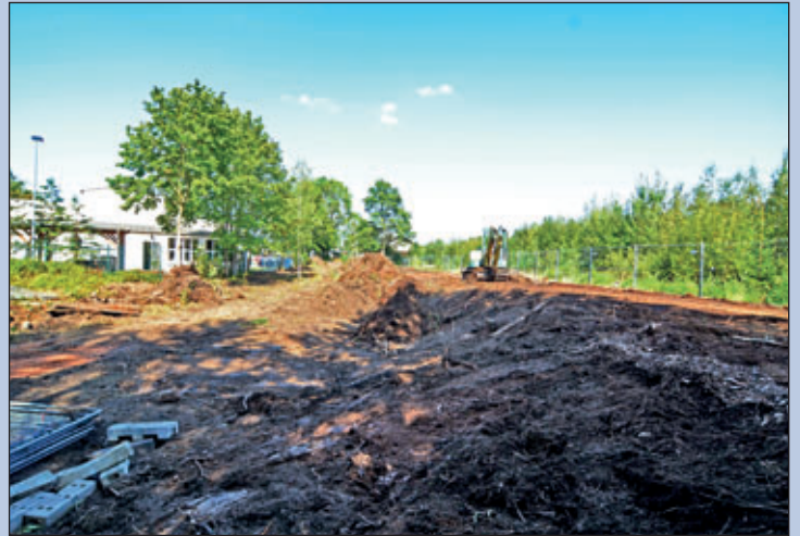
Bitumenarbeiten für Wegebau (Stand: November 2019)
