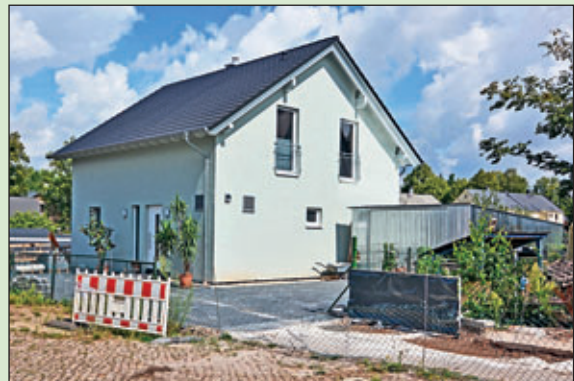
Poststraße 8a – Wohnhaus
