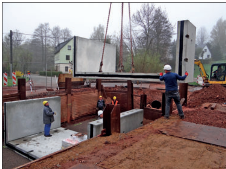
Anlieferung der ersten Brückenteile im April 2018.
