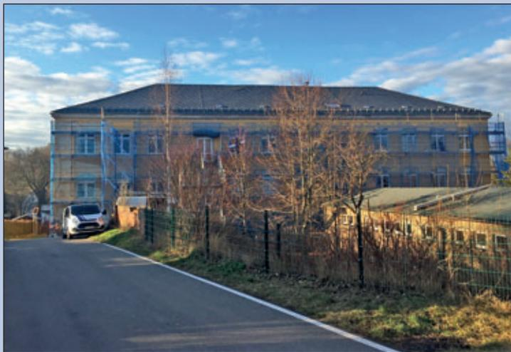
Fertigstellung Schornsteinabbruch, Natursteinsanierung (Fenstergewände und Gurt- und Traufgesimse) sowie Erneuerung des Außenputzes an Gebäuderückseite des Schulgebäude
