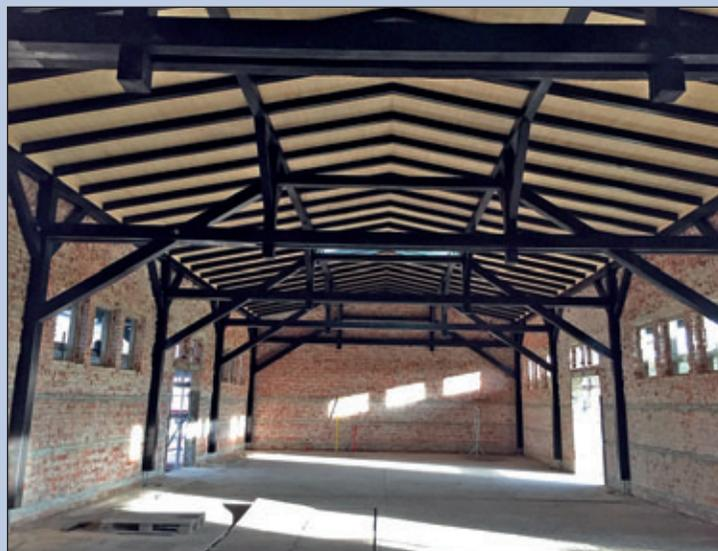
Fertigstellung Dachsanierung (Holztragwerk) Bestandsgebäude Ansicht von innen
