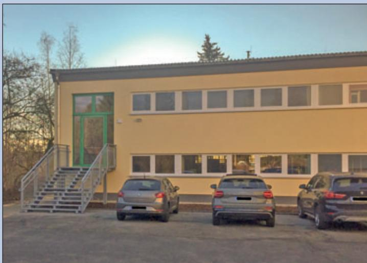
Fertigstellung des 2. Bauabschnittes in 12/2019 Errichten einer Fluchttreppe und Anbringen eines WDVS einschl. Erneuerung der Fenster- und Haustürelemente an der Nordwestseite
