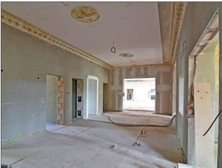
Eingangsfoyer Erdgeschoss im Bauteil A mit historischem, restaurierten Deckenfries und Stuck-Rosetten an einer neuen Unterdecke (vor Malerarbeiten)
