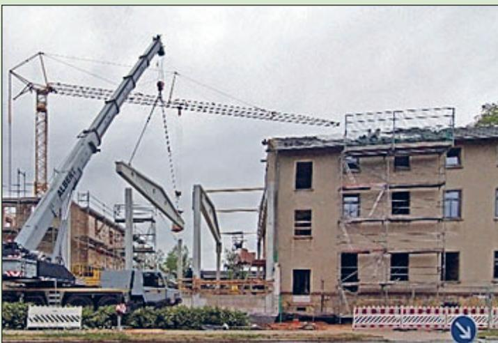
Montage Bauteil M Stahlbeton- Skelett- Bauweise – Juli 2019
