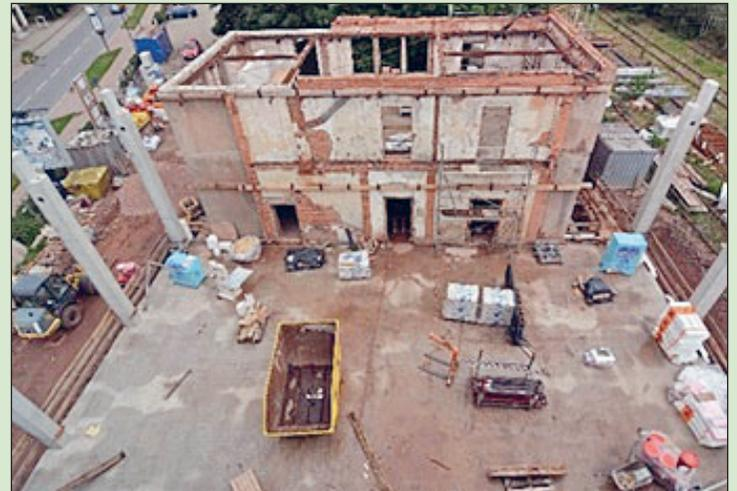
Rohbauarbeiten in Ausführung, Kellerdecke Bauteil M (Ersatzneubau) fertiggestellt – Juni 2019
