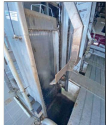
Bild 3: Grobrechen im Rechenhaus (Bild: WAD GmbH)
