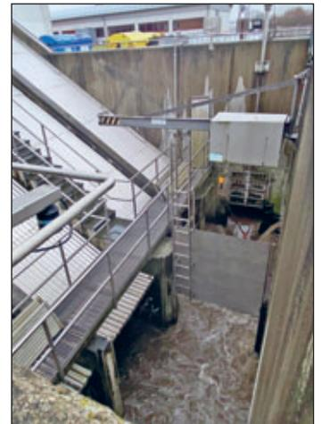
Bild 2: Jede unserer Schnecken schafft es, 560 l/s anzuheben. Der Zulauf bei Trockenwetter beträgt durchschnittlich 17.000 Kubikmeter Abwasser/Tag. Bei Regenwetter verzeichnen wir einen Zulauf von bis zu 1200l/s. Dafür ist unsere Kläranlage auch bei Havariefällen ausgelegt, um eine stabile Abwasserbehandlung zu gewährleisten
