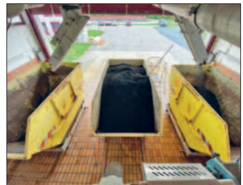
Bild 4: ... zum Containerraum der Schlammpresse (Fotos: WAD GmbH)
