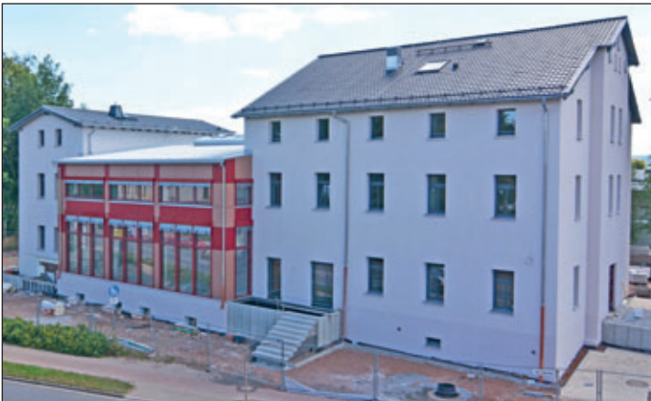
Fertiggestellte Fassade Straßenseite
