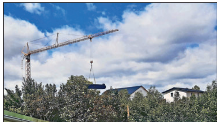
Anlieferung Regenwasserzisterne mittels Kran
