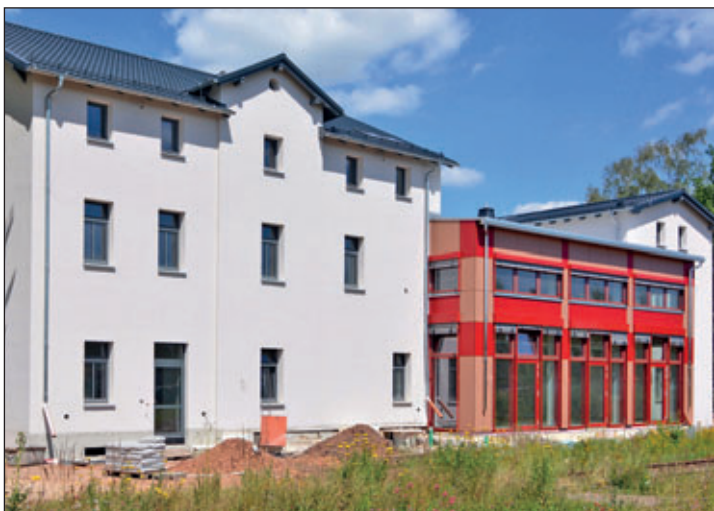
Fertiggestellte Fassade Rückseite
