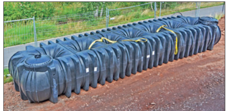
Anlieferung Regenwasserzisterne mittels Kran
