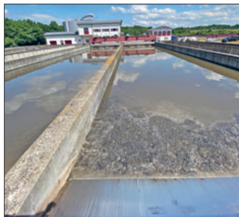
Bild 3: Schwimmschlamm, der regelmäßig entfernt wird
