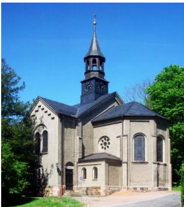
Außenansicht der Kreuzkirche Lugau | Foto: W. Frech
