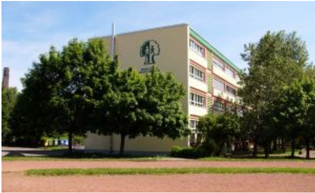
Außenansicht der Oberschule am Steegenwald
